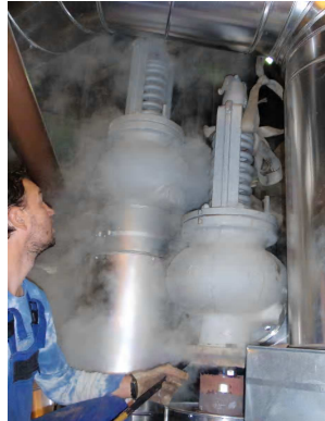
Montáže pojistných ventilů
