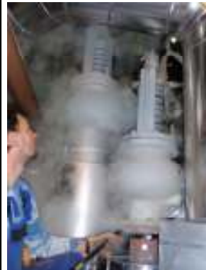
Montáž pojistných ventilů
