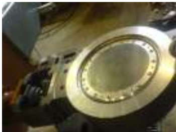
APD – rychlouzávěrné klapky na vstupním parovodu TG, vysokotlaká šoupátka s úpravou pro stojánek
