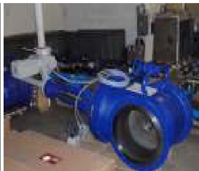
Šoupátko DN500 s pohonem Schiebel Vstupní parovod do TG, pára
