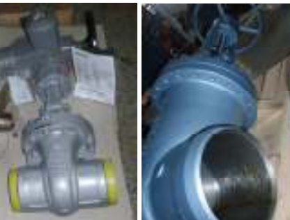
APD – pojistný ventil protitlaku TG a šoupátka vysokotlaká pro vstupní parovod TG
