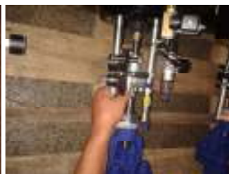
APD – rychlouzávěrné klapky na vstupním parovodu TG, vysokotlaká šoupátka s úpravou pro stojánek
