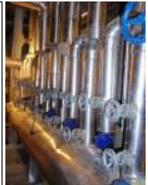
APD - Montáž odvodnění odvodňovací baterie
